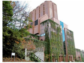
緑橋換気所(壁面緑化)
