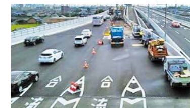
同一交通規制内での作業集約化
