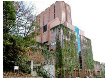
緑橋換気所(壁面緑化)
