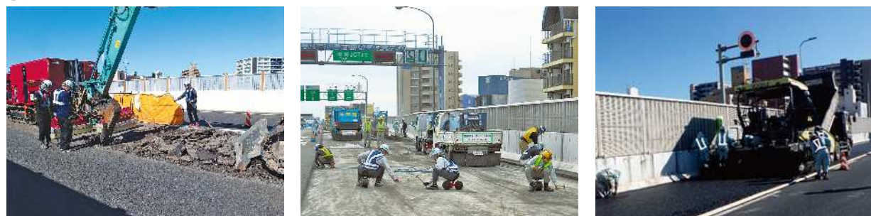
鋼床版上の舗装撤去 (IH技術による特殊機械)
