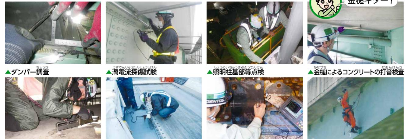
▲ダンパー調査 ▲渦電流探傷試験 ▲照明柱基部等点検 ▲金植によるコンクリートの打音検査 ▲ASR 膨張量測定 ▲磁気探傷試験 ▲超音波探傷試験 ▲ロープ高所作業
