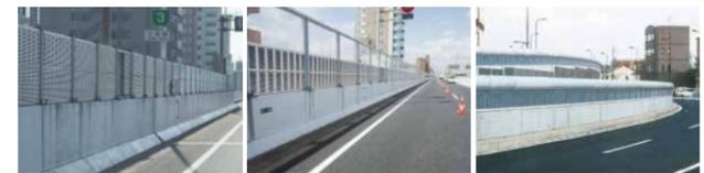
▲通常遮音壁 ▲透光性遮音壁 ▲先端改良型遮音壁
