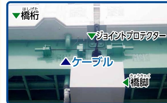
▲橋桁の落下防止システム
