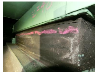
支承における損傷例
