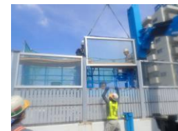
遮音壁・透光板の取替
