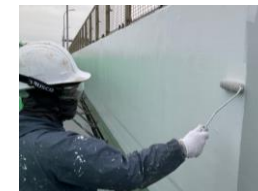
高欄の補修・表面保護・ 鋼製高欄の腐食・孔食対策
