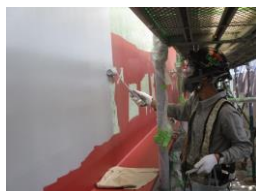
鋼桁の塗装
