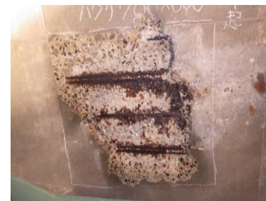
RC床版における損傷例
