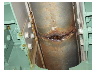
伸縮装置における損傷例
