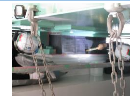
ゴム支承のき裂補修
