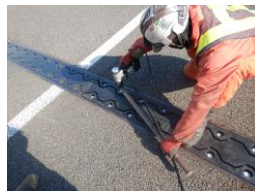
伸縮継手の取替
