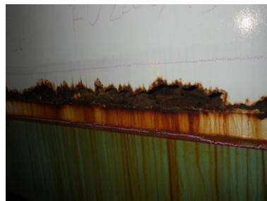
鋼製高欄における損傷例
