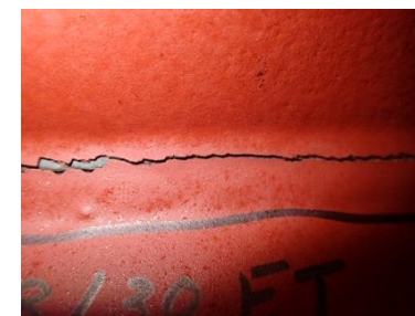
鋼床版における損傷例
