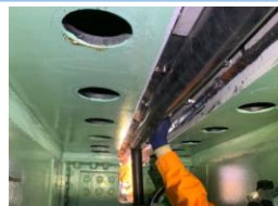
伸縮装置の 排水構造改良
