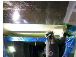
床版下面の補強・ 剥落防止・表面保護
