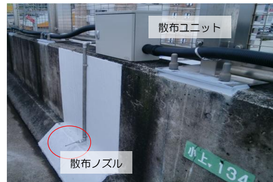
凍結防止剤の自動散布装置
