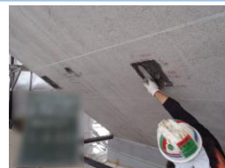
コンクリート橋脚の 補修・表面保護
