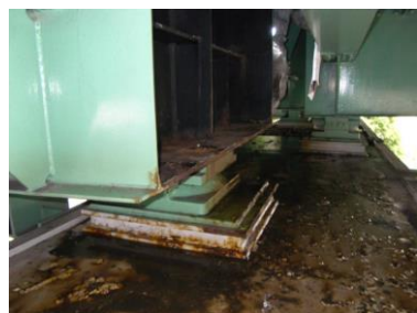
鋼製橋脚における損傷例
