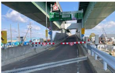
入口閉鎖装置設置例
