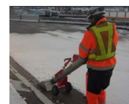
除雪作業の状況
