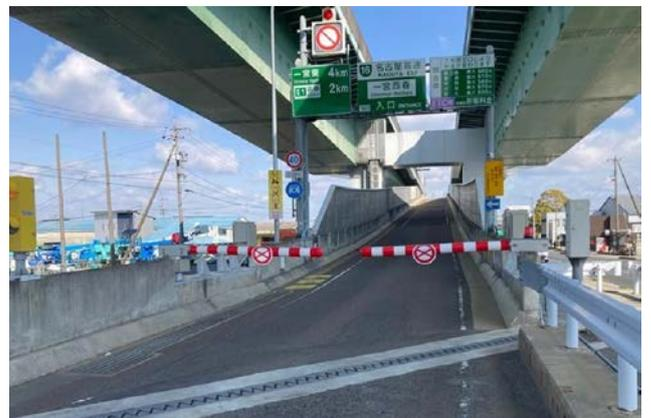
入口閉鎖装置（高速16号一宮線西春入口）
